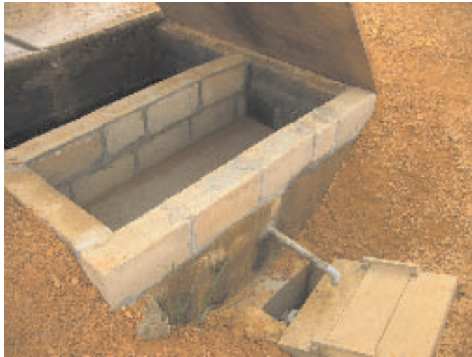
Bassin débourbeur et de séparation des hydrocarbures © Bernard CASSAGNE
