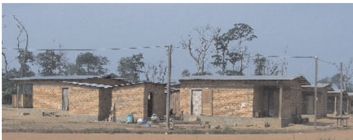
Cases construites sur la base-vie de Ngombé – société IFO au Congo © Antoine COUTURIER
