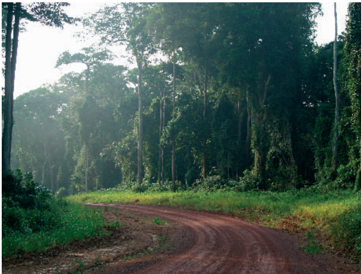
Piste d'exploitation, chantier CEB © Benoît DEMARQUEZ
